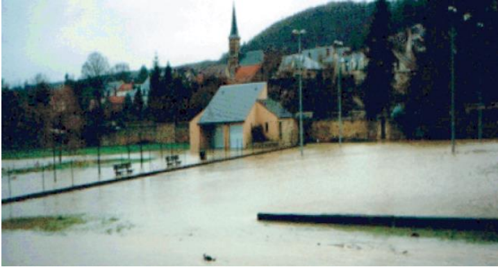
Photo effectuée en 1989 avant les travaux du bassin de retenue.
